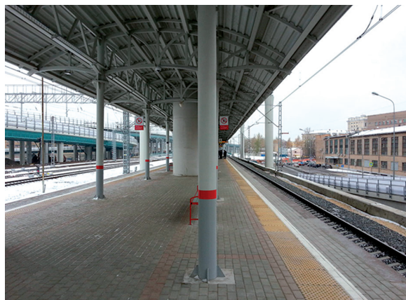
Рисунок 16. Покрытие железнодорожного перрона
